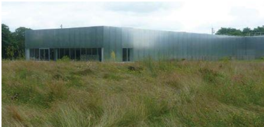
Intégration paysagère du bâti commercial par utilisation de matériaux sobres et qualitatifs (source : Atelier LD)
