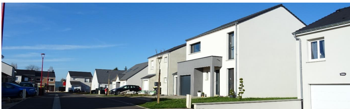
CARACTERISTIQUES ARCHITECTURALES DES NOUVELLES CONSTRUCTIONS SITUÉES RUE DE L'ABBE BLANCHEBARBE
